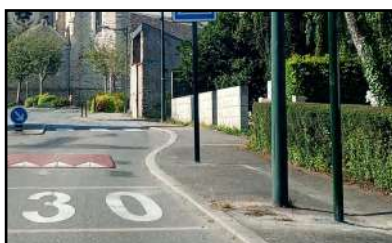
Travaux de sécurisation
