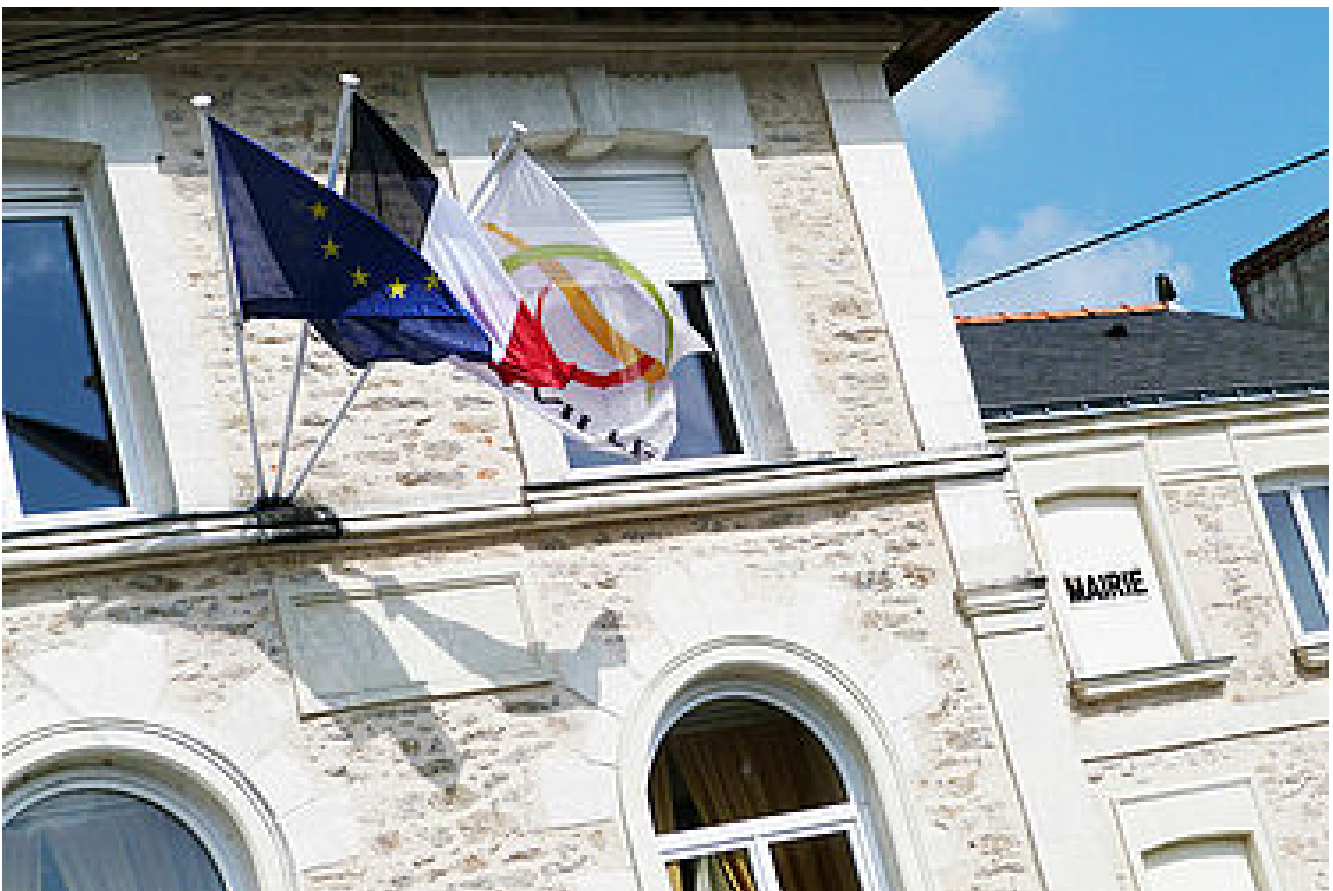
Services administratifs-La Poste-Médiathèque
